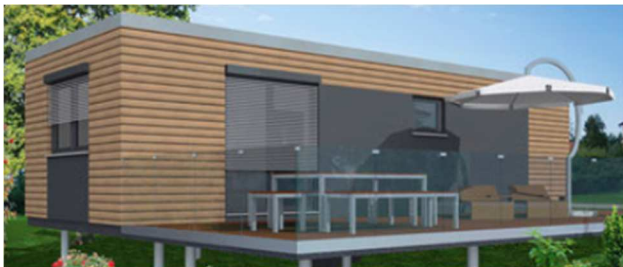
Tiny-Modulhaus (auf Punktfundament)
